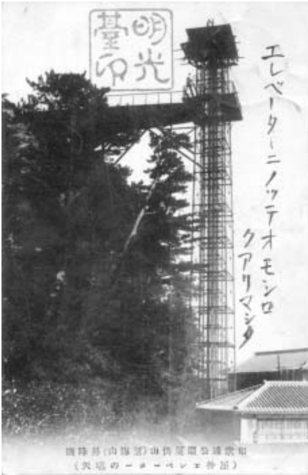
図2 真供山と望海樓の屋外エレベーター
